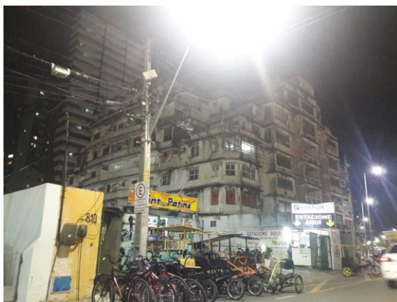
Figura 7: Edifício São Pedro, 09/08/2016.
