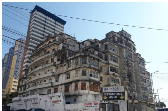
Figura 6: Edifício São Pedro, 30/08/2016.
